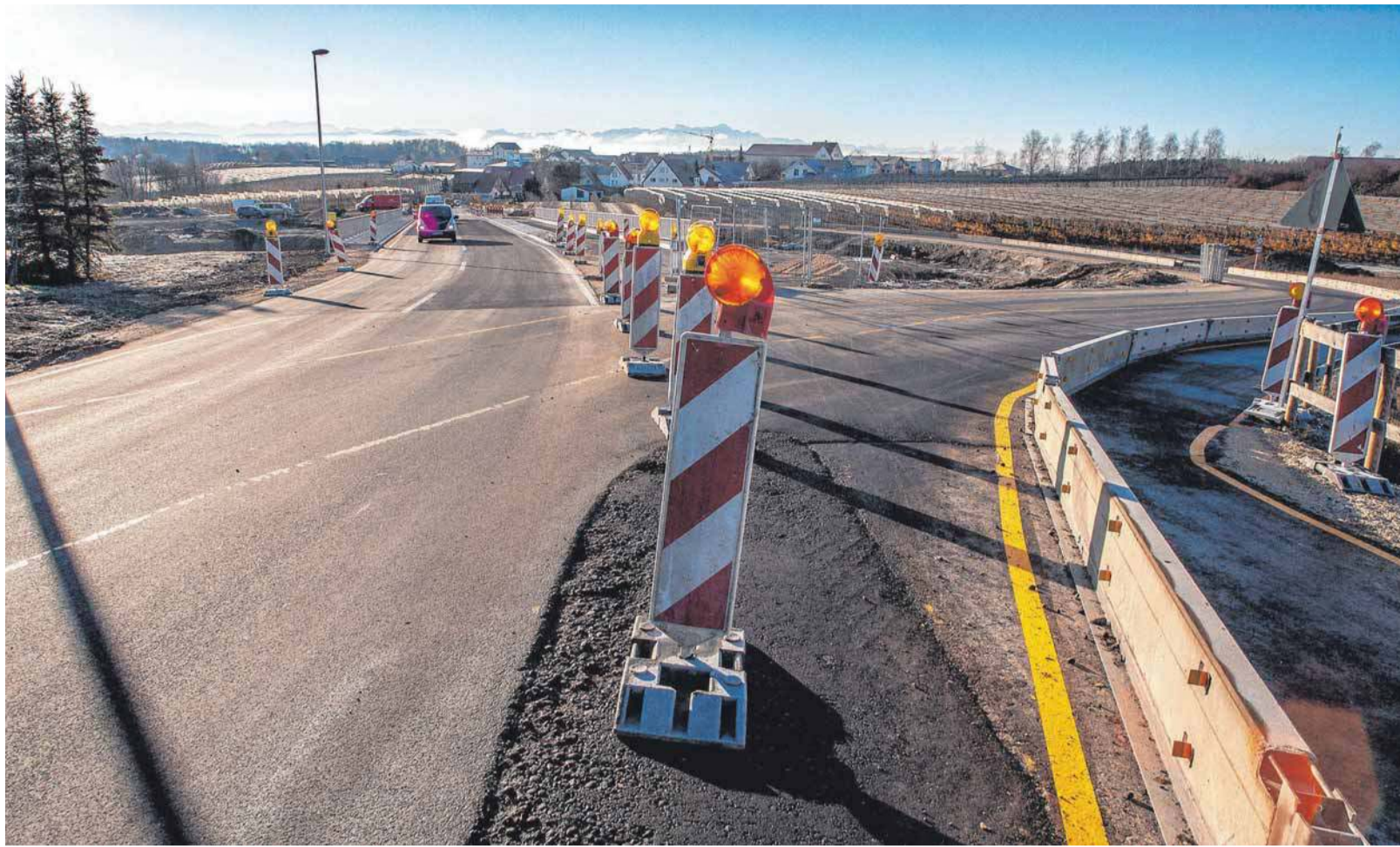
Die Schnetzenhauser Brücke über die B 31-neu ist fertiggestellt und für den Verkehr freigegeben.
